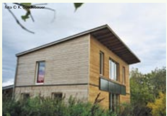
Pasivní dům v rakouském Perchtoldsdorfu. Jako tepelná izolace jsou mimo jiné použity slaměné battly.
