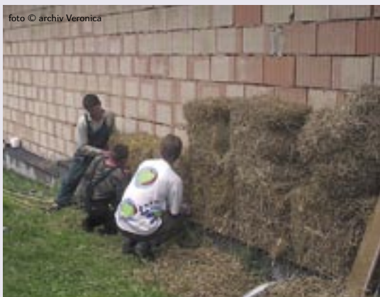
Přišívání slaměných balíků ke stěně skladu moštu.
