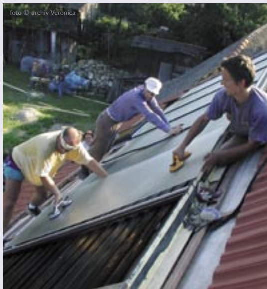
Instalace kolektoru na střechu vyžaduje týmovou práci.
