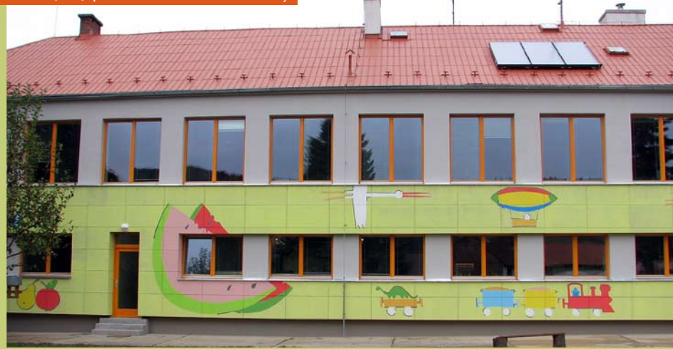
Pitín (ČR) | rekonstrukce mateřské školy
